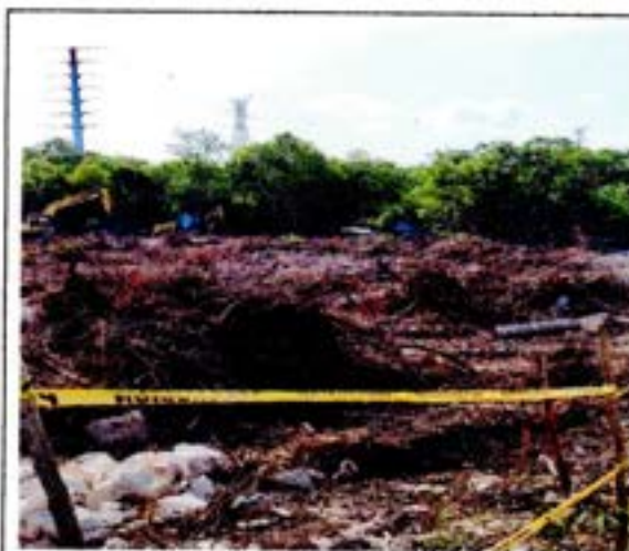
Fotografía 1. Inicios de obras de casas CONAVI.
