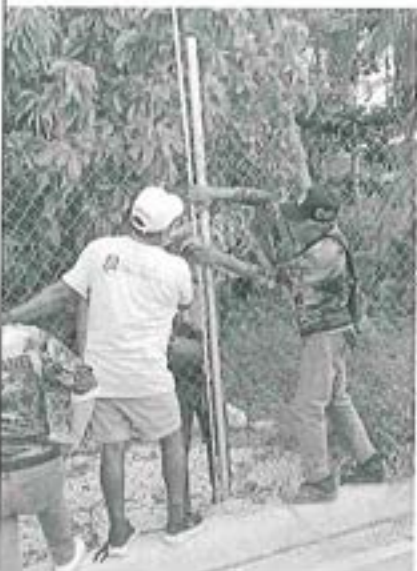
Imagen 1. Colocación de malla
