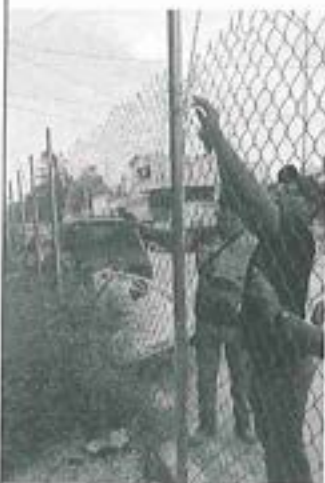
Imagen 3. Jornada de trabajo para la colocación de malla
