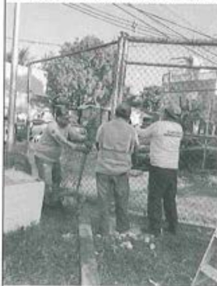
Imagen 4. Colocación de reja de acceso
