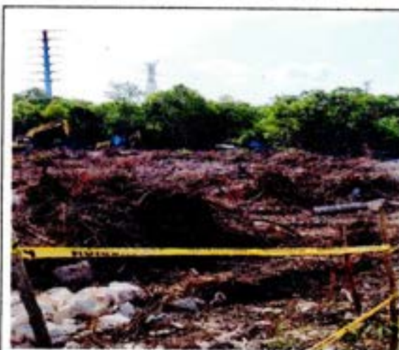
Fotografía 1. Inicios de obras de casas CONAVI.
